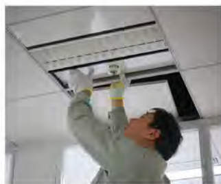
スプリンクラー設置工事中
